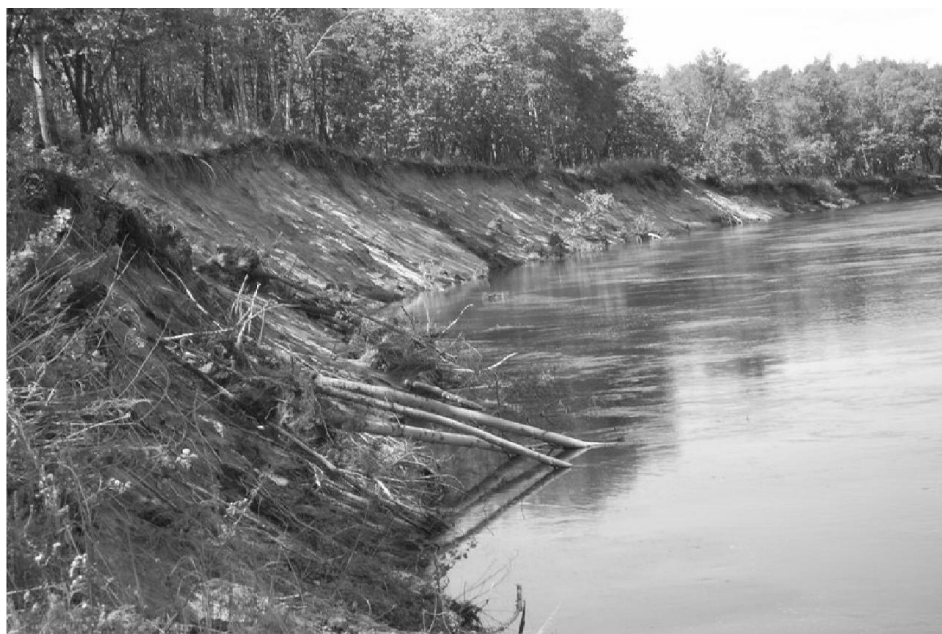
Рис. 2. Берегоразрушение в районе сопки Разрытая (между селами Казанка и Дубовое), угрожающее автодороге, 28.05.2010 [1].
